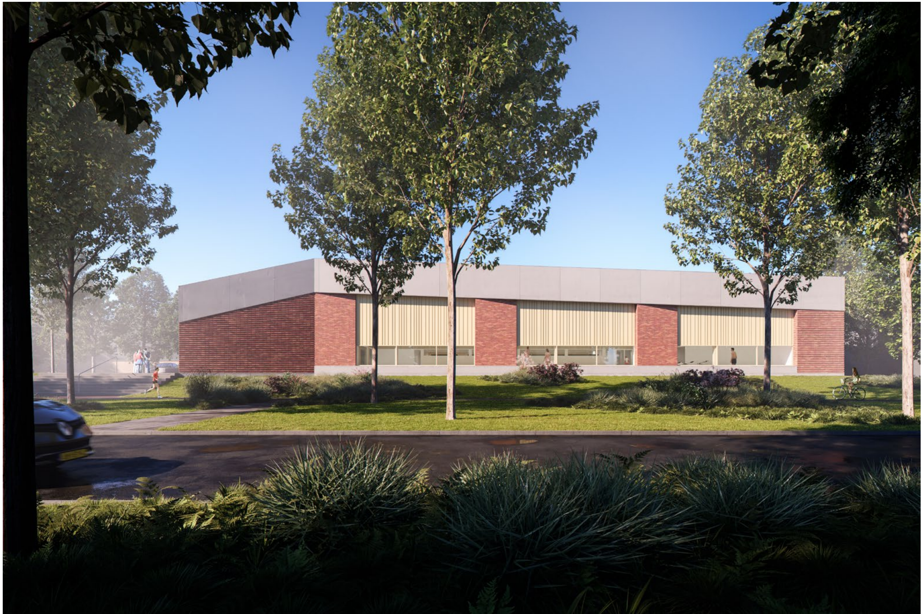
ZWEMZAAL ZIJDE VANUIT KUIPERSWEG
