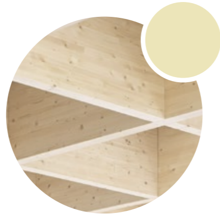
Houten liggers en kolommen
