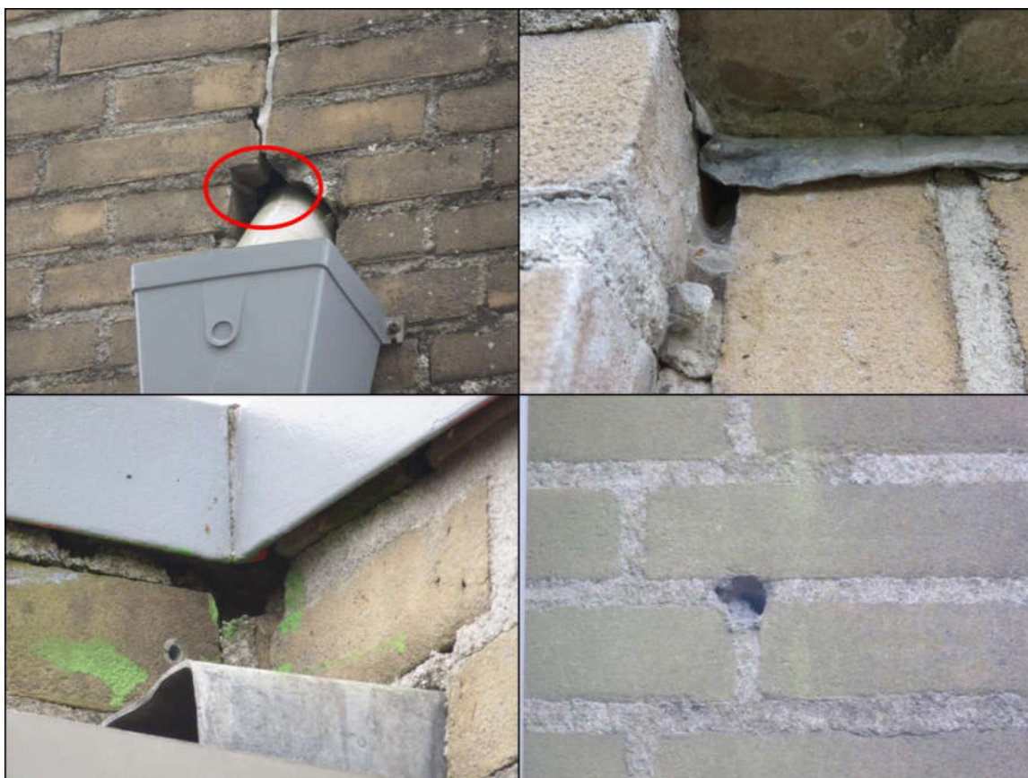
Figuur 2.3. Kieren en gaten rondom het zwembad die mogelijk toegangen tot verblijfplaatsen van vleermuizen vormen.
