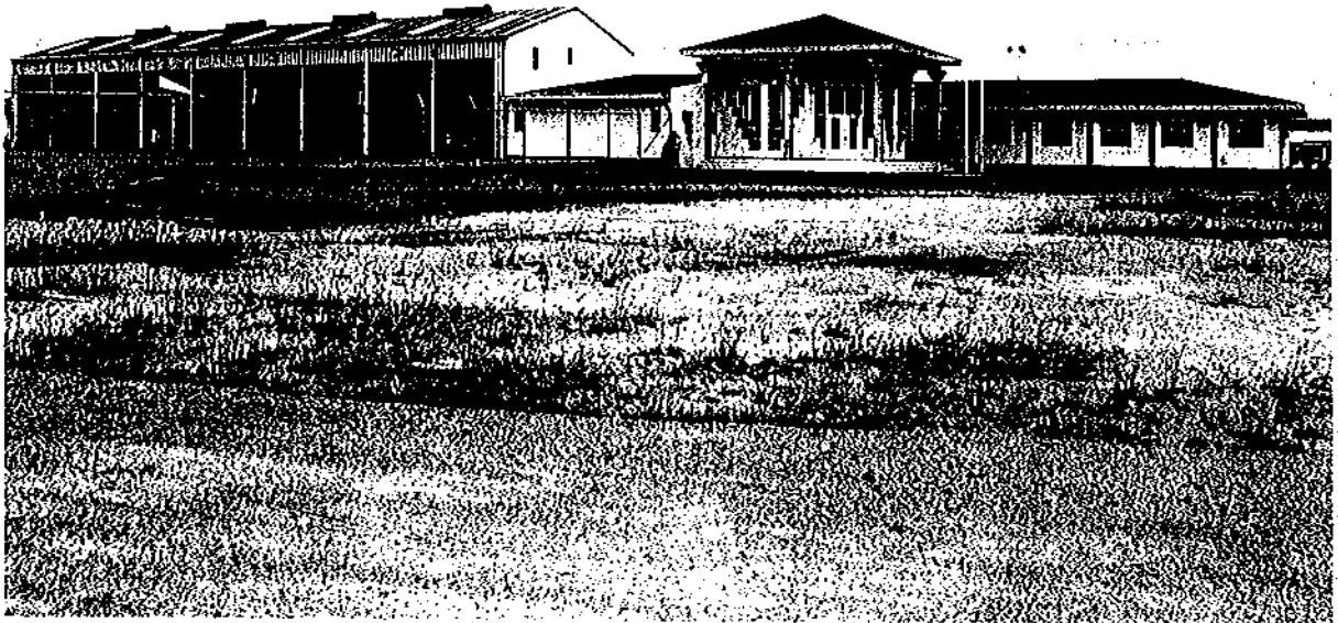
Afb. 3: Kantoorgebouw Dienst Brandweer
