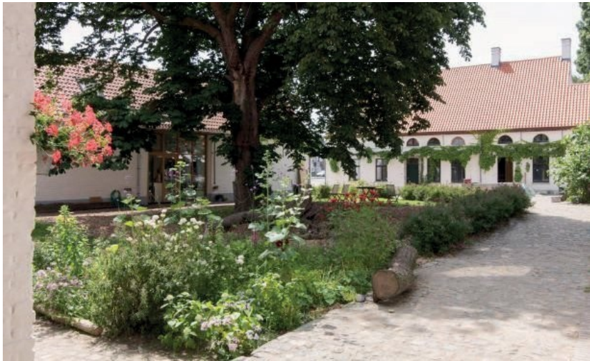
Figuur 33: Hof Ter beempt, Zingem (BE): renovatie van vierkantshoeve tot cohousingproject (AnnO architecten)
