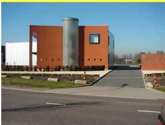
Bedrijfsgebouw aan de Middelweg
