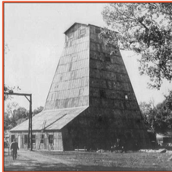
Figuur 3.3: Schacht IV van Staatsmijn Emma
