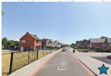
Asfalt + klinkers (strekken)
