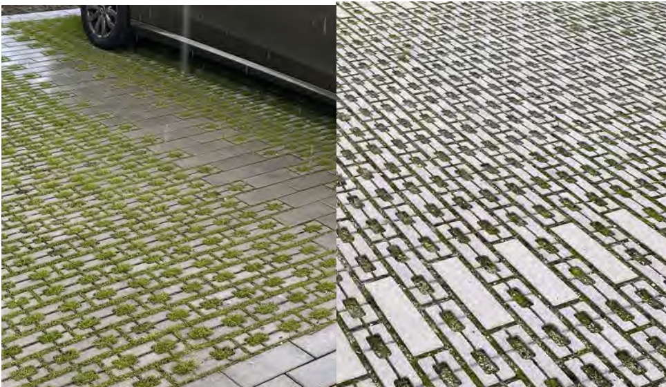
Met NCB klinker type 2 of 3 in legverband
