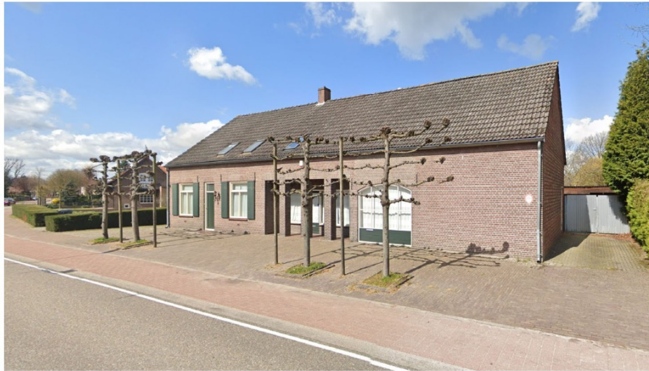
Dorpstraat 34: deze langgevelboerderij wordt gesplitst in 2 halfvrijstaande woningen
