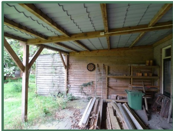
Onderzijde afdak aanbouw
