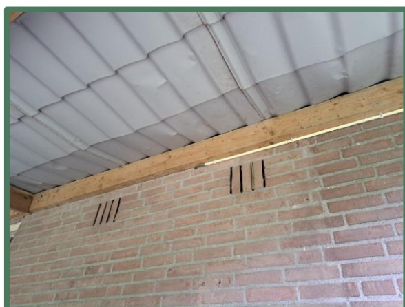
Met kunststof gesloten stootvoegen
