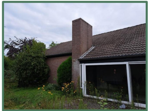
Overzicht te slopen aanbouw
