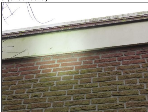
Foto C: Ruimte onder boeiborden, aan alle zijden van de kopercentrale
