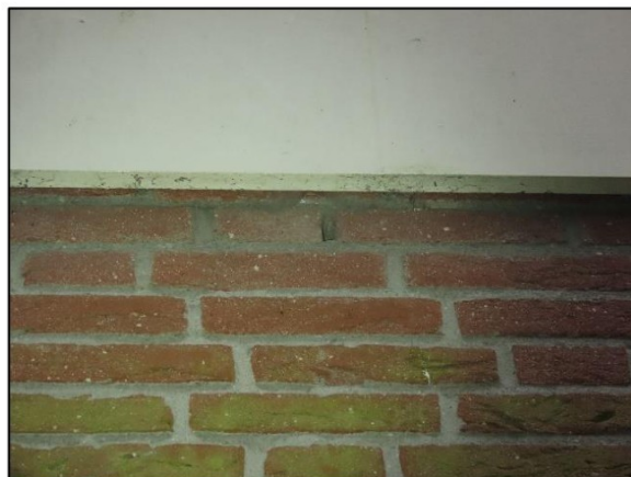
Foto B: Kleine stootvoegen, aan alle zijden van de kopercentrale
