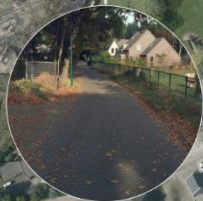
Ontbreken van trottoir
