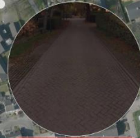
Ontbreken van trottoir
