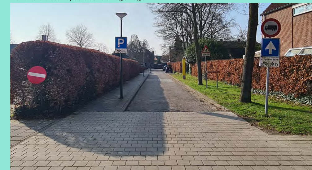
Domineestraat zuidelijk deel: parkeerveld met hoge hagen, enkelzijdig voetpad, smalle rijbaan en eenrichtingsverkeer vanaf Sterrepad, groenstrook met enkele langspakeervakken
