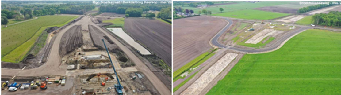
Bouwwerkzaamheden zijn in volle gang
