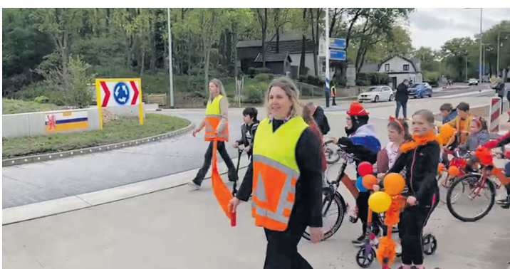
De rotonde in Well is vorige week feestelijk geopend. Nu wordt nog hard gewerkt bij de aansluiting op de Kasteellaan. Deze is binnenkort klaar en dan kunnen we gebruik maken van de afslag naar Well.
