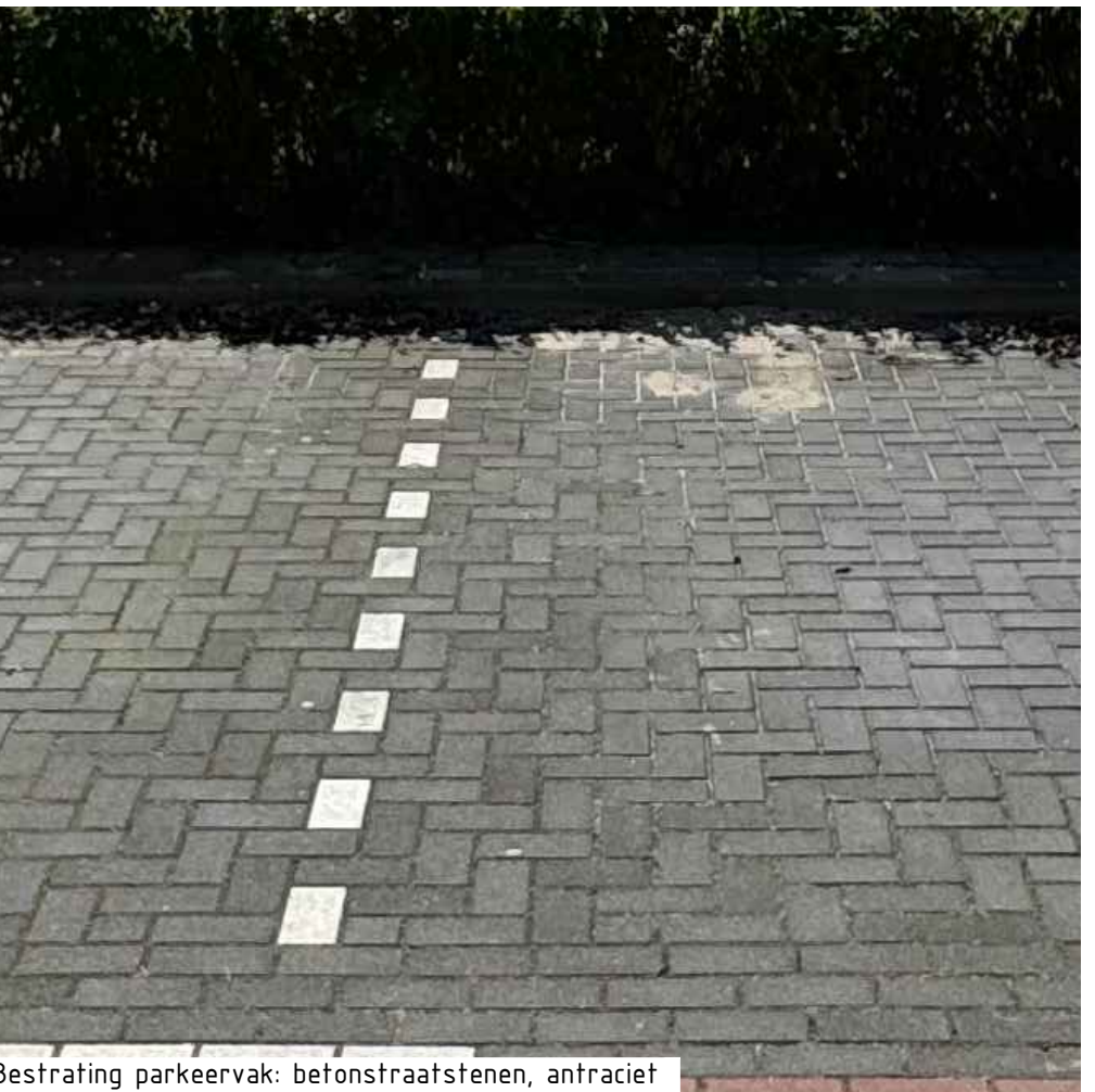
Bestrating parkeervak: betonstraatsstenen, antraciet
