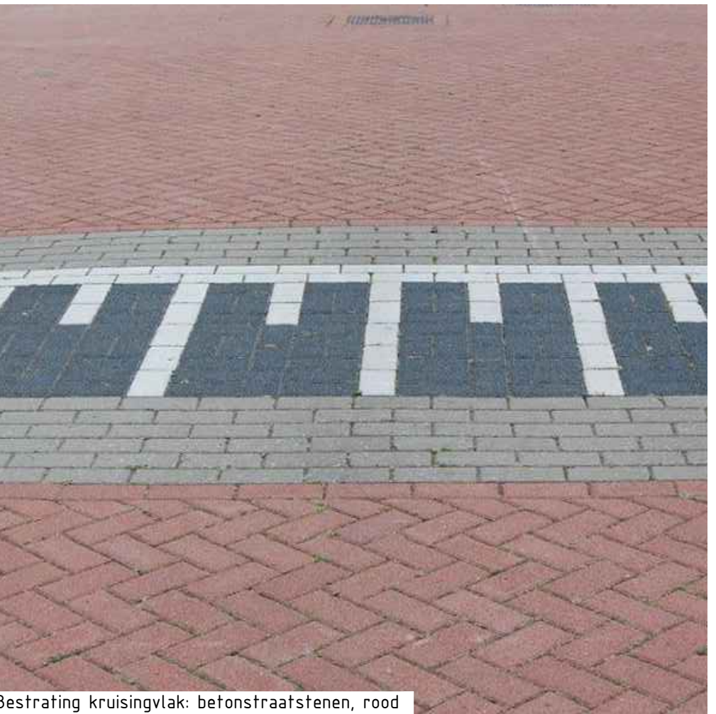
Bestrating kruisingvlak: betonstraatsstenen, rood
