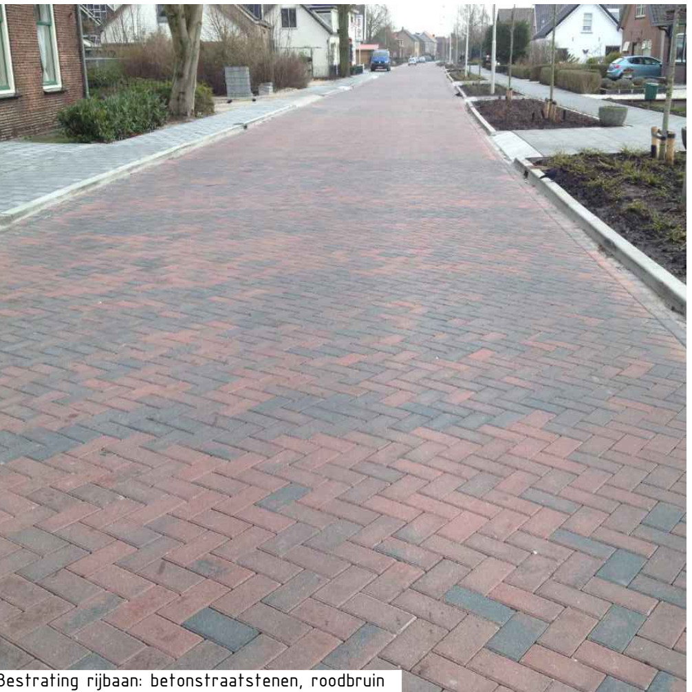
Bestrating rijbaan: betonstraatsstenen, roodbruin
