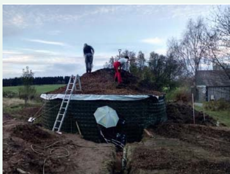
Aanleg van een biomeiler met houtsnippers uit landschapselementen; opbrengst: warmte en compost
