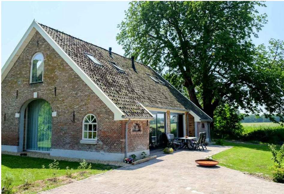
Oude karakteristieke schuur omgebouwd tot woning in plaats van sloop en nieuwbouw.
