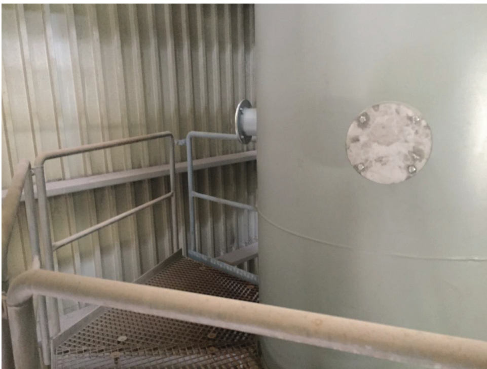
Foto meetpunten van de schoorsteen behorende tot de asfaltoven
