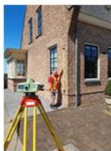
Meetwerk in uitvoering
