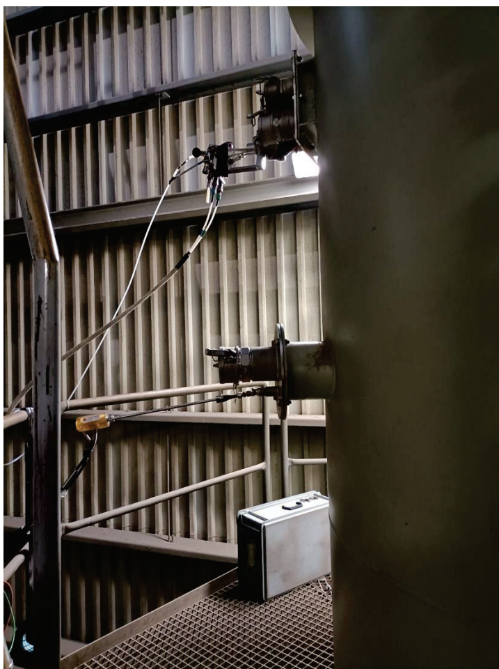
Foto 2: Meetlocatie schoorsteen bij Asphalt Produktie Maatschappij (A.P.M.) B.V., gelegen aan Van Konijnenburgweg 54 te Bergen op Zoom
