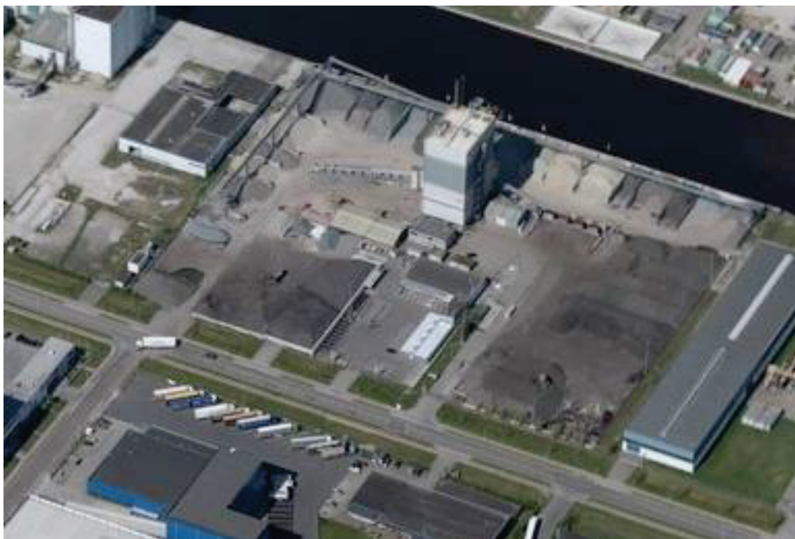
Foto 1: Overzichtsfoto Asfalt Produktie Maatschappij (A.P.M.) B.V., gelegen aan Van Konijnenburgweg 54 te Bergen op Zoom
