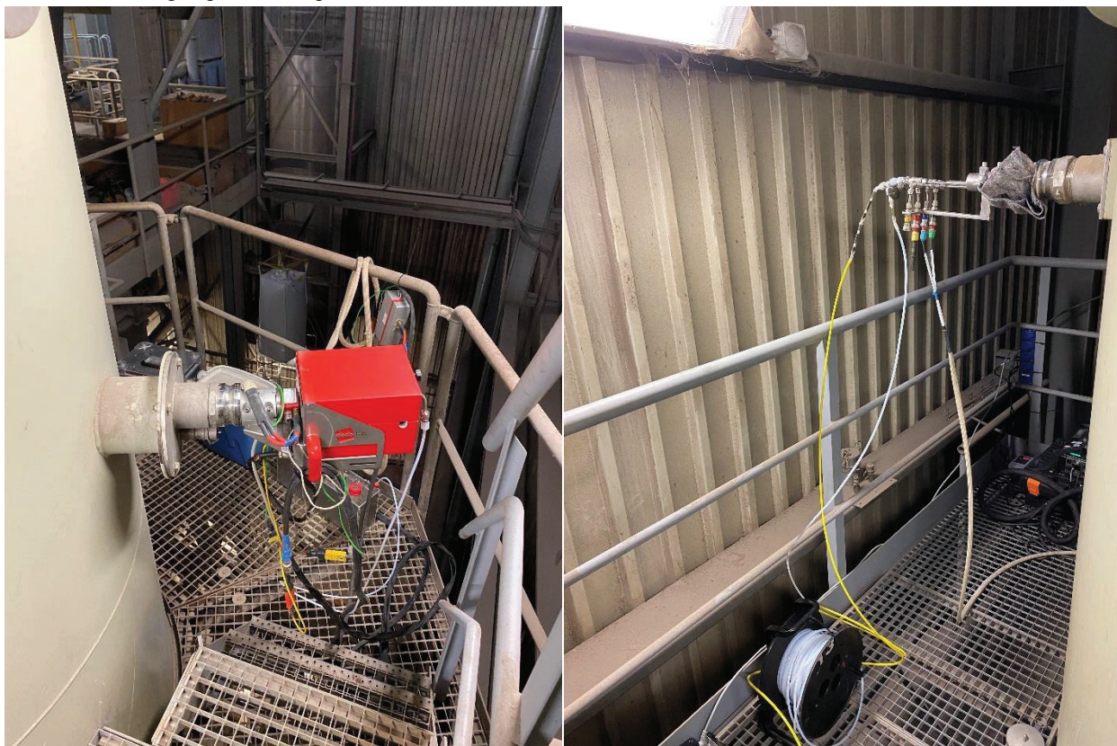
Foto 2 en 3: Meetlocatie schoorsteen bij Asfalt Produktie Maatschappij (A.P.M.) B.V., gelegen aan Van Konijnenburgweg 54 te Bergen op Zoom
