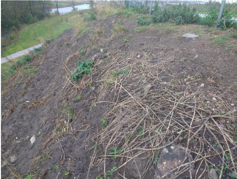
Foto 16. Blootligging talud wielerbaan
