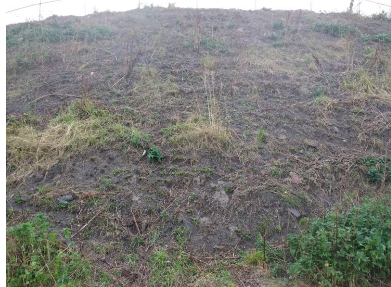
Foto 17. Blootligging talud wielerbaan
