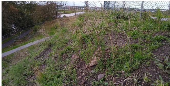
Foto 16 Blootligging talud wielerbaan
