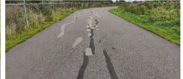
Foto 33: 53 scheuren wielerbaan gedicht
