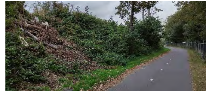
Foto 12: 22 Talud zuidkant Aagtenpark
