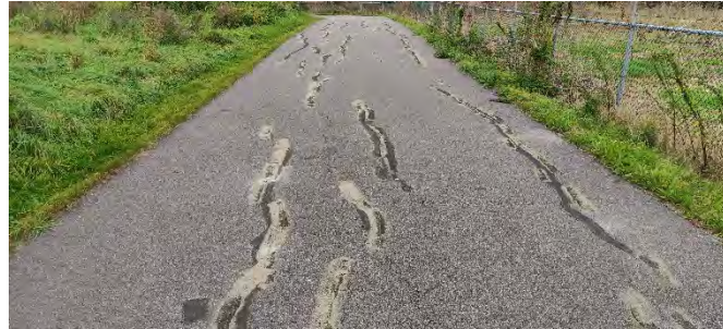
Foto 32: 52 scheuren wielerbaan gedicht
