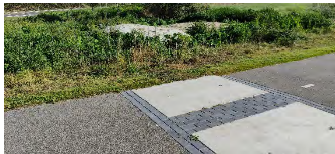
Foto 71: 162 gedumpt beton en zand
