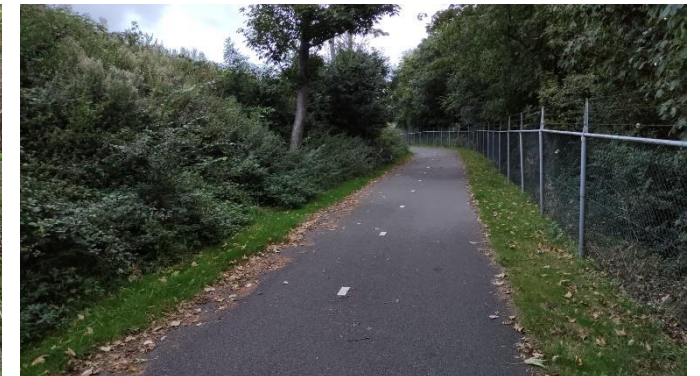
Foto 12: 22 Talud zuidkant Aagtenpark
