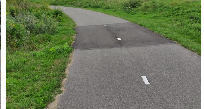
Foto 69: 160 Hersteld asfalt
