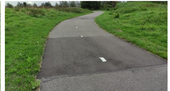
Foto 72: 166 en 167 Asfalt hersteld
