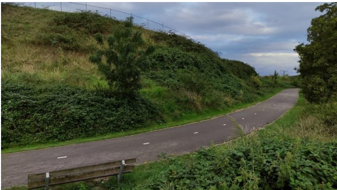
Foto 28: 45b Talud Zuidoostkant Aagtenpark
