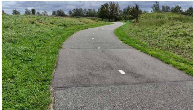
Foto 71: 166 en 167 Hersteld asfaltvak
