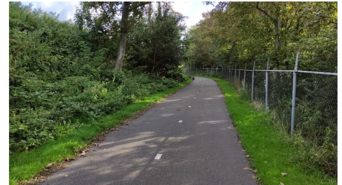
Foto 12: 22 Talud zijkant Aagtenpark
