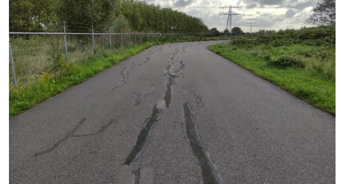
Foto 33: 53 Scheuren wielerbaan hersteld
