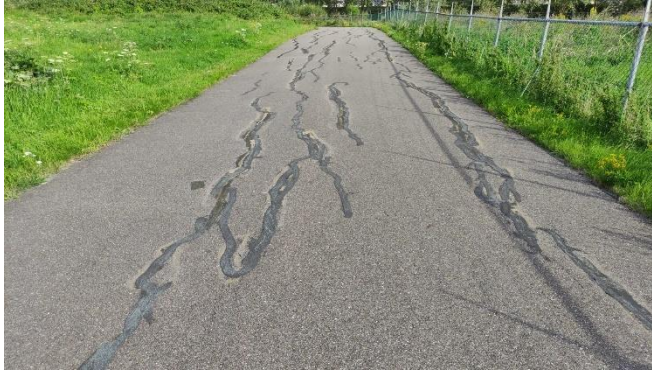
Foto 32: 52 Scheuren wielerbaan hersteld
