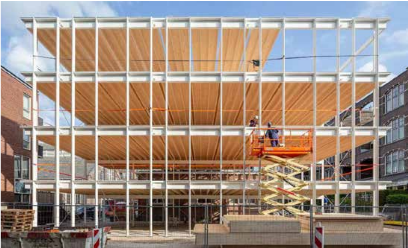
Flexibele en modulaire bouwsystemen die aanpasbaar zijn naar de toekomst toe
