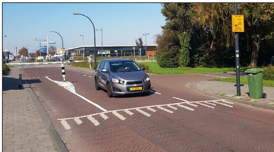
Figuur 2.4: De aangelegde chicane ten hoogte van het Elzenhof als extra 30 km/u maatregel.
