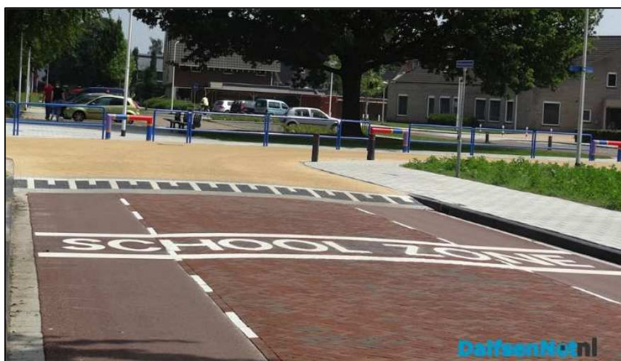
Figuur 5.4: Voorbeeld van het weergeven van een schoolzone op een kruispunt (bron:DalfsenNet.nl)
