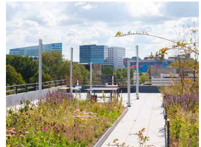
Groen dak met gebruiksfunctie
