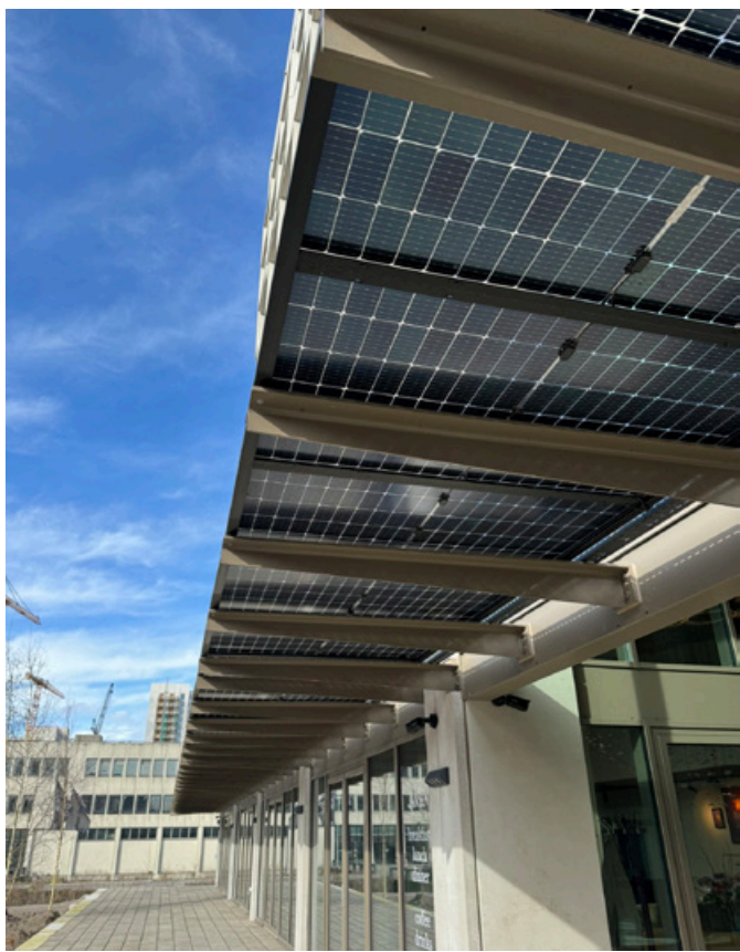
Zonnepanelen geïntegreerd in een luifel
