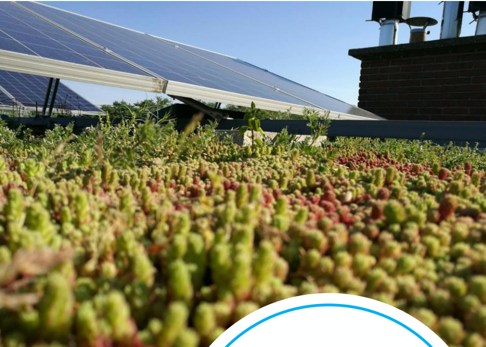
Groen dak met zonnepanelen
