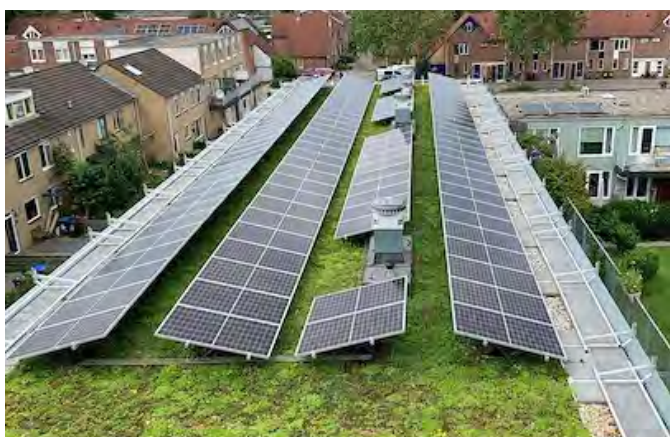
Groene daken met zonnepanelen
