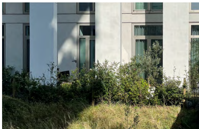
Overgangszone tussen privéterras en openbare ruimte
