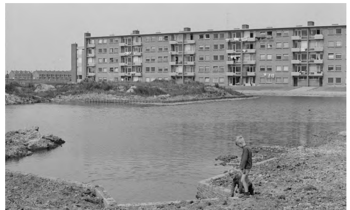
Oosterwijk in aanbouw
