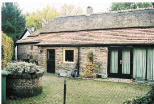
Aanzicht achtergevel linkerkant
