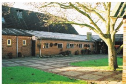
Aanzicht rechterkant achtergevel
