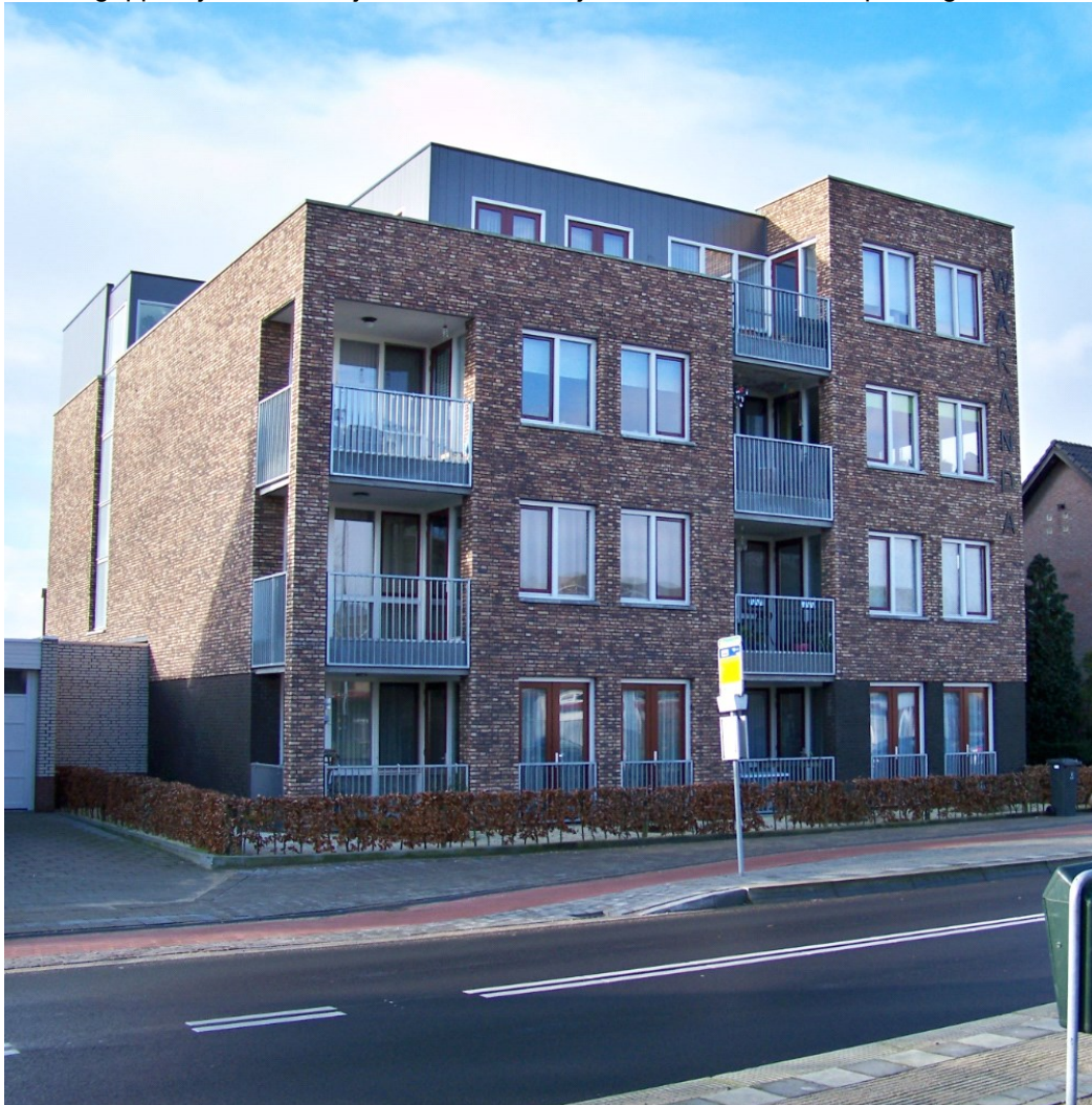
Waranda, complex huurwoningen Europalaan te Bladel
