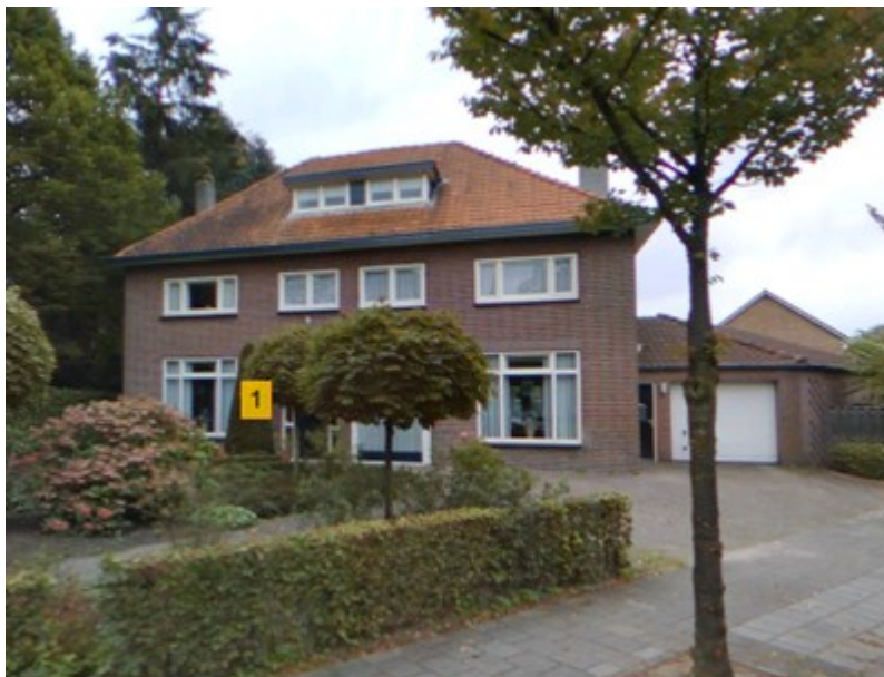
Ombouw woning tot 4 appartementen te Hapert
