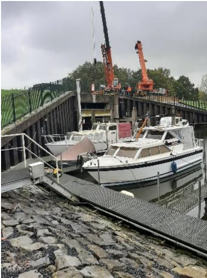
Figuur 9: Testen dubbelwerkende functie keersluis Lage Zwaluwe (nov 2021)
