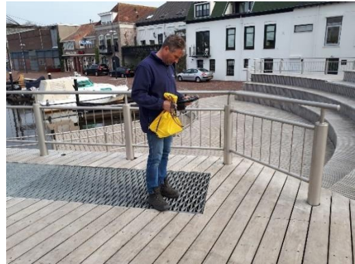
Figuur 10: Voorbeeld inspectie kunstwerk
