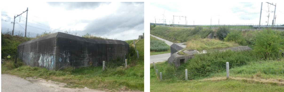
Afb. 43. De bunker (Baupunkt 98) ten oosten van de spoorbrug bij Moerdijk. Op de rechter foto is de aangebouwde tobruk te zien. Uiterst rechts op de rechter foto is een hoek van de kazemat zichtbaar. Foto's: ADC ArcheoProjecten.
