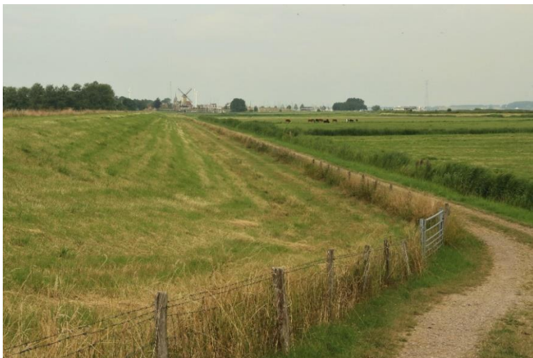
Figuur 3-3: Een kering afgesloten door een randvoorziening: puntdraadraster
