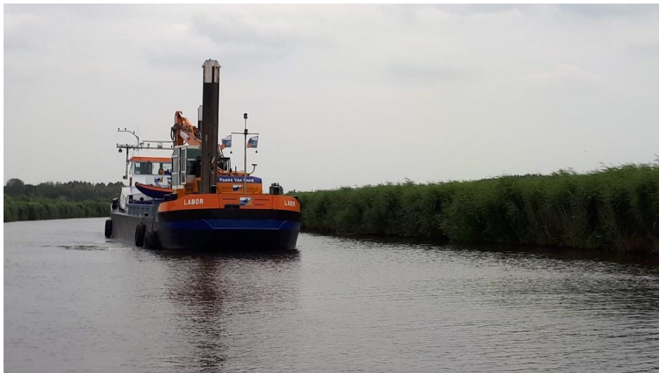
Figuur 5-17: Onderhoud aan vaarwegen, baggeren
