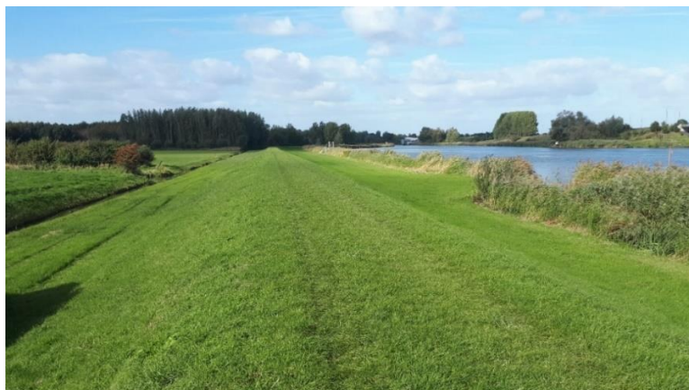
Figuur 4-4: Waterkering, links het binnenwater in de teensloot en rechts het buitenwater
