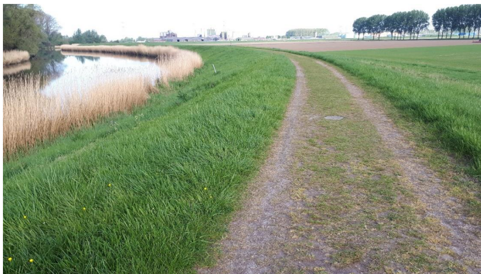
Figuur 5-1: links het buitenwater: een vaarweg met een rietoever, rechts het inspectiepad op de kruin van de kering en aan de landzijde de polder welke tegen het buitenwater wordt beschermd
