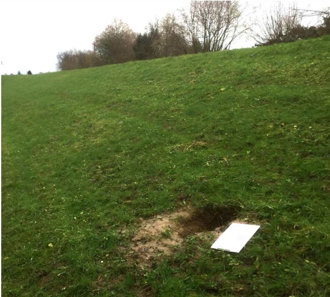
Figuur 15. Voorbeeld ondiepe dassenpijp in waterkering.
