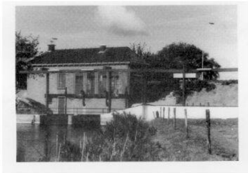
Interieur en exterieur van het gemaal Brooymans in de Gewijzigde Cruislandpolders.
