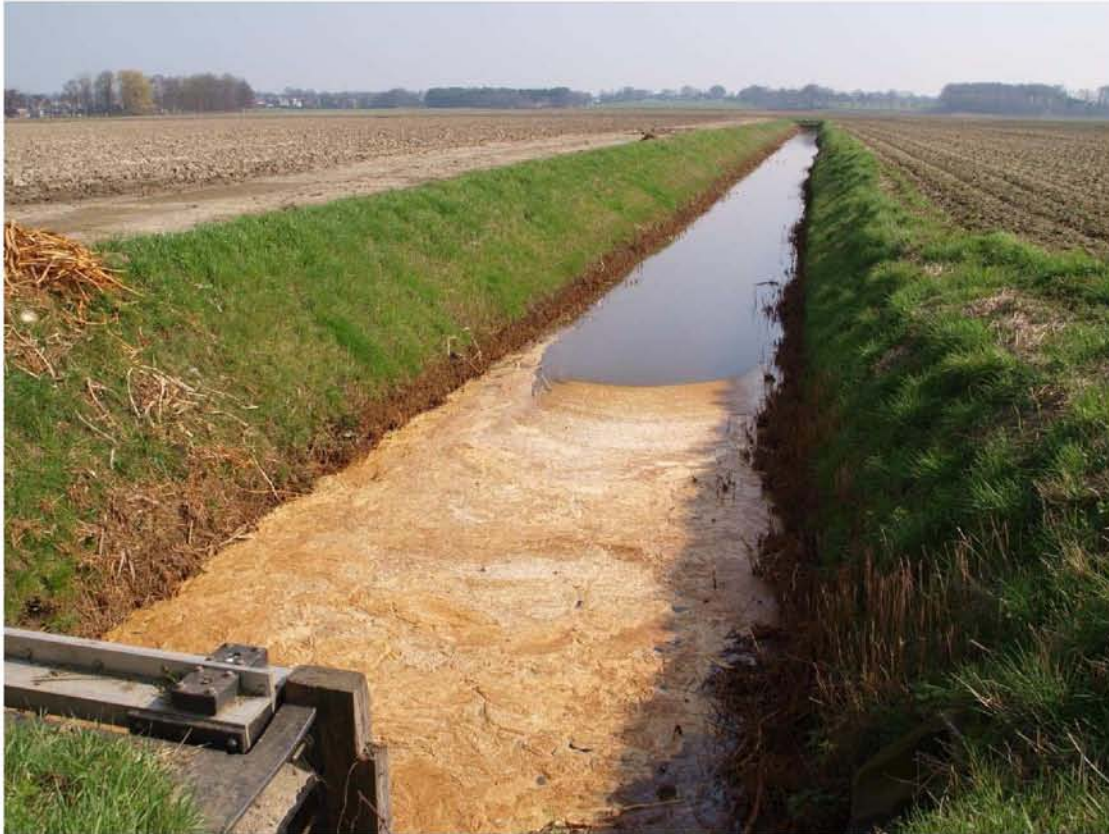
Fig. 3.9: Putterkreek met links onder in beeld de stuw Schipperskil. Drijvende, rode ijzerhoudende vlokken hebben zich voor de stuw opgehoopt. Foto 16 maart 2017.
