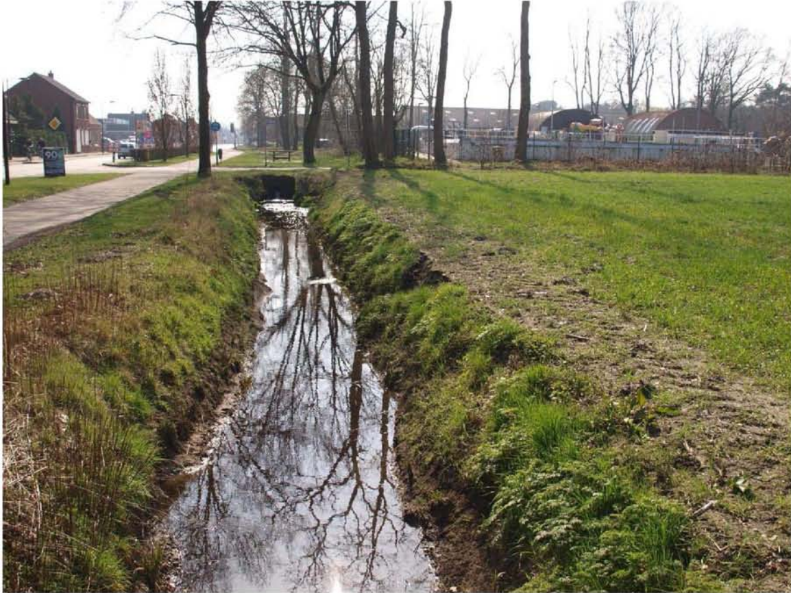
Fig. 3.11: Lozingspunt van de rioolwaterzuiveringsinstallatie Putte in afvoersloot naar de Kabeljouwbeek. Foto 16 maart 2017.
