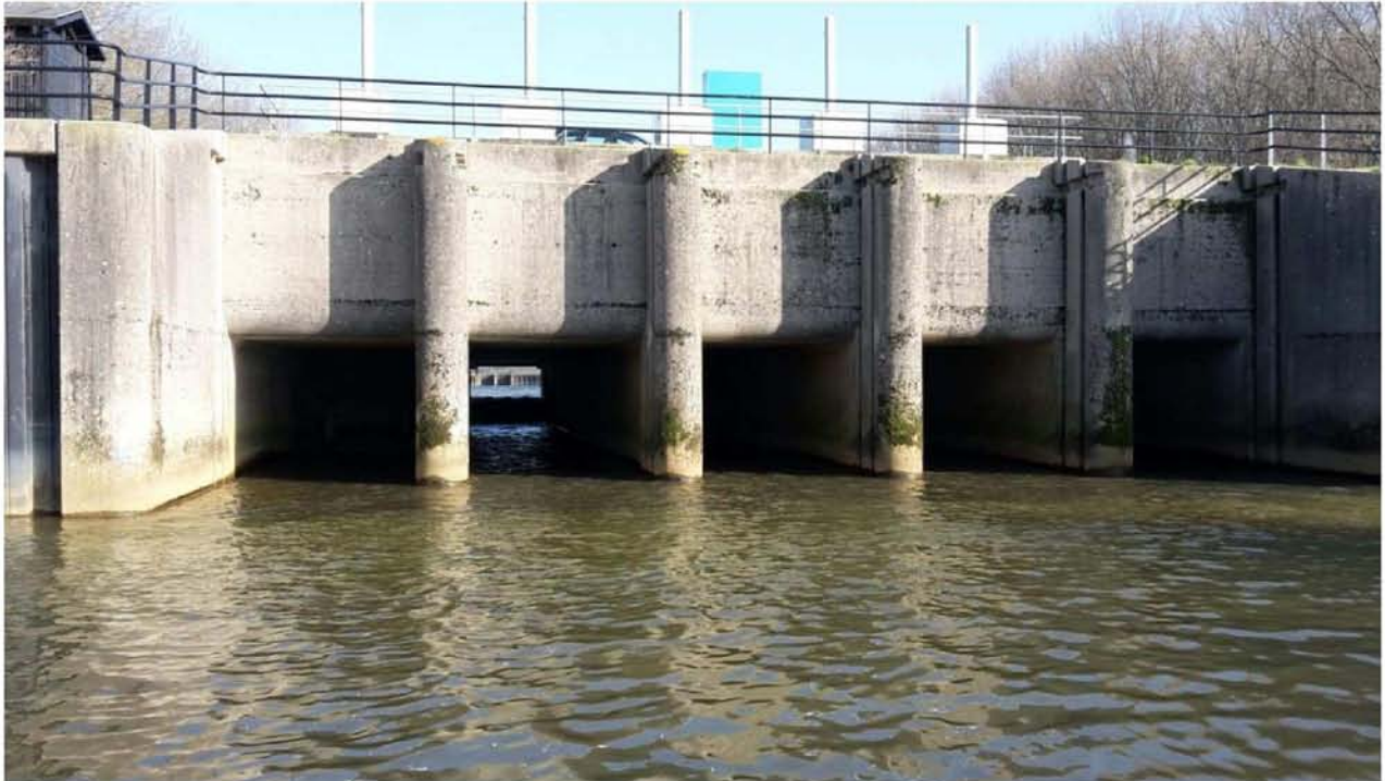
Fig. 3.2: Stuw Brugweg, waterschap Scheldestromen.
