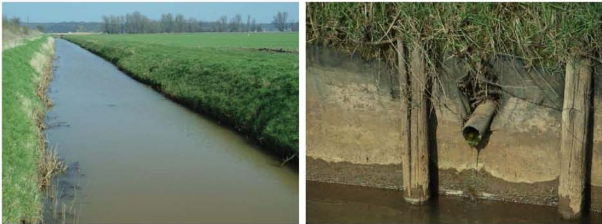
Fig. 3.16: De Agger langs Schenkeldijk (links). Oeverbeschoeiing met buisdrainage ten westen van A4 (rechts). Foto's 16 maart 2017.
