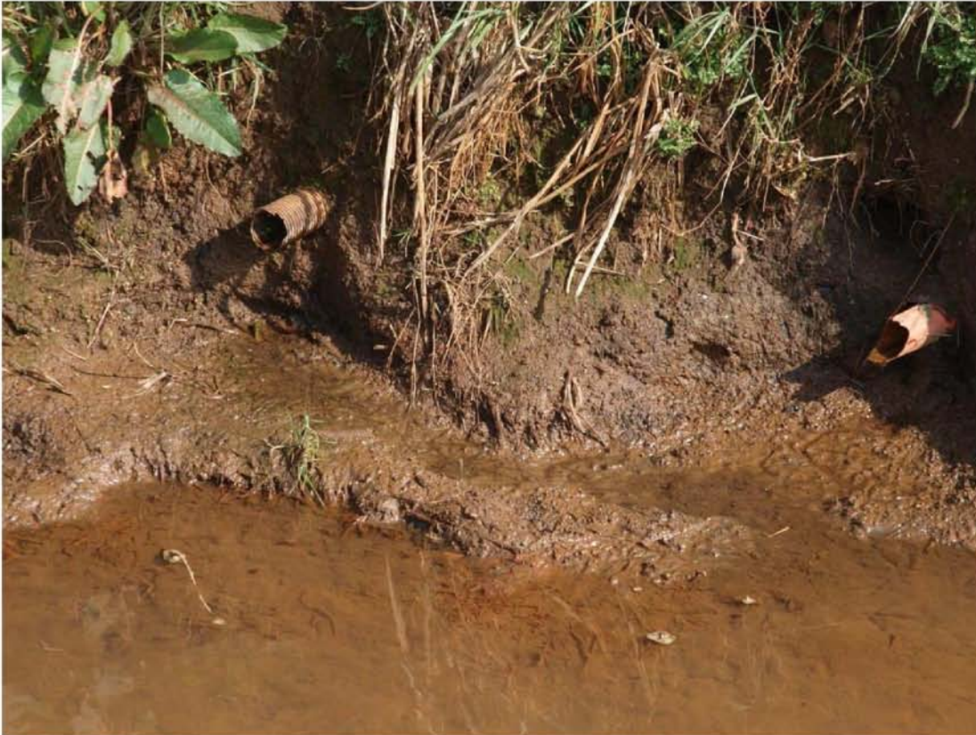
Fig. 3.8: Lozingspunten van de buisdrainage van een landbouwperceel op De Agger. Foto 16 maart 2017.
