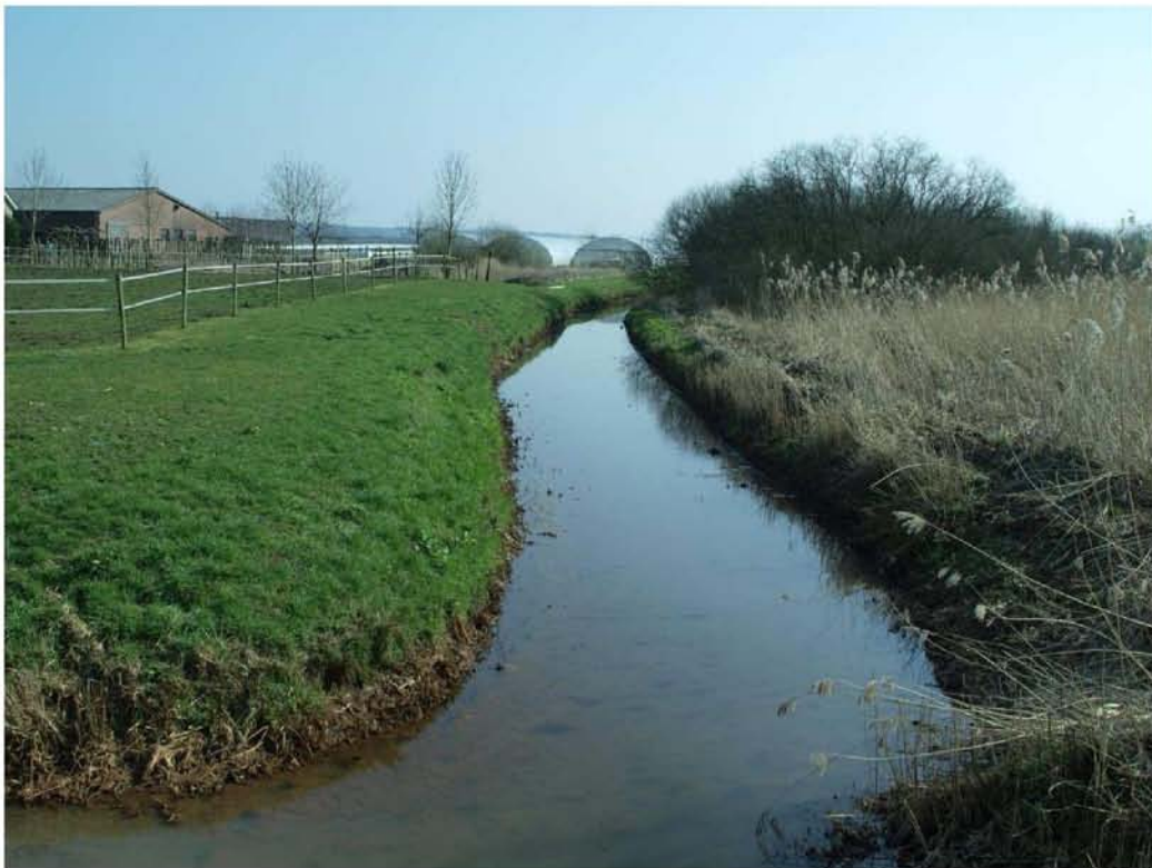
Fig. 3.14: Bos- en moerasstrook langs het noordelijk deel van het KRW-waterlichaam ter hoogte van de Grindweg. Foto 16 maart 2017.
