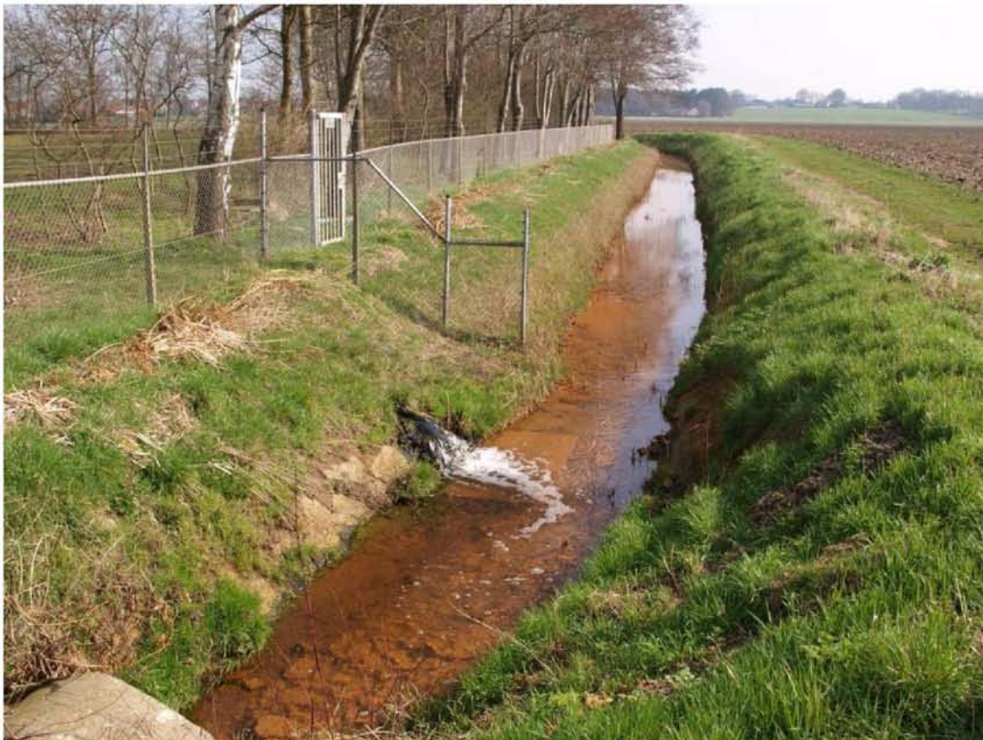
Fig. 3.7: Lozing van effluent van de rioolwaterzuiveringsinstallatie Ossendrecht op de Schipperskil. De rode kleur van het water van de Schipperskil duidt op ijzerhoudend kwelwater. Foto 16 maart 2017.
