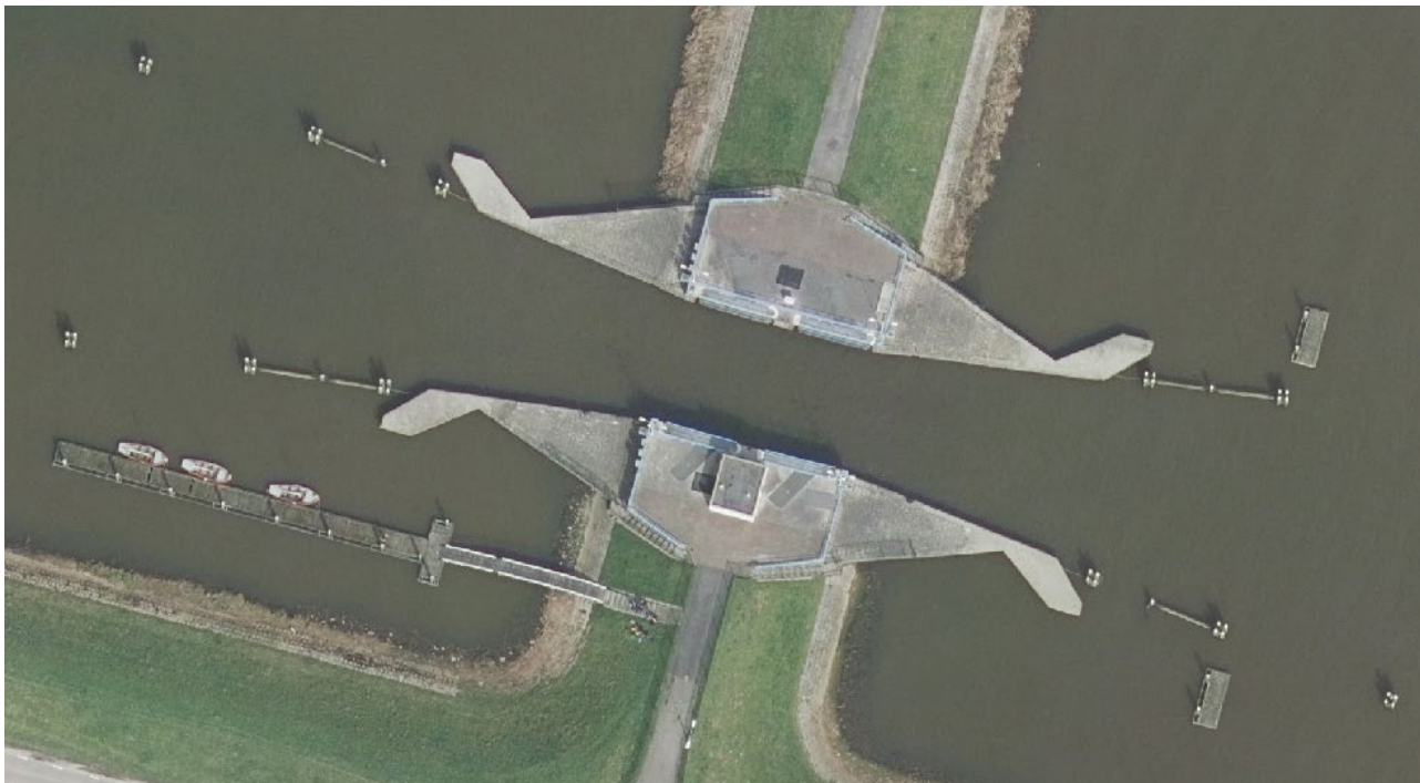
Figuur 51. Luchtfoto keersluis Schipdiep
