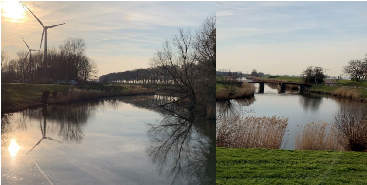
Figuur 38. Traject 1 bij Bovenlandsesluis (links) en bij sluis Waalwijk (rechts)
