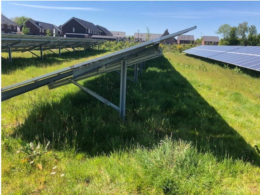
Solarpark de Kwekerij, Hengelo
