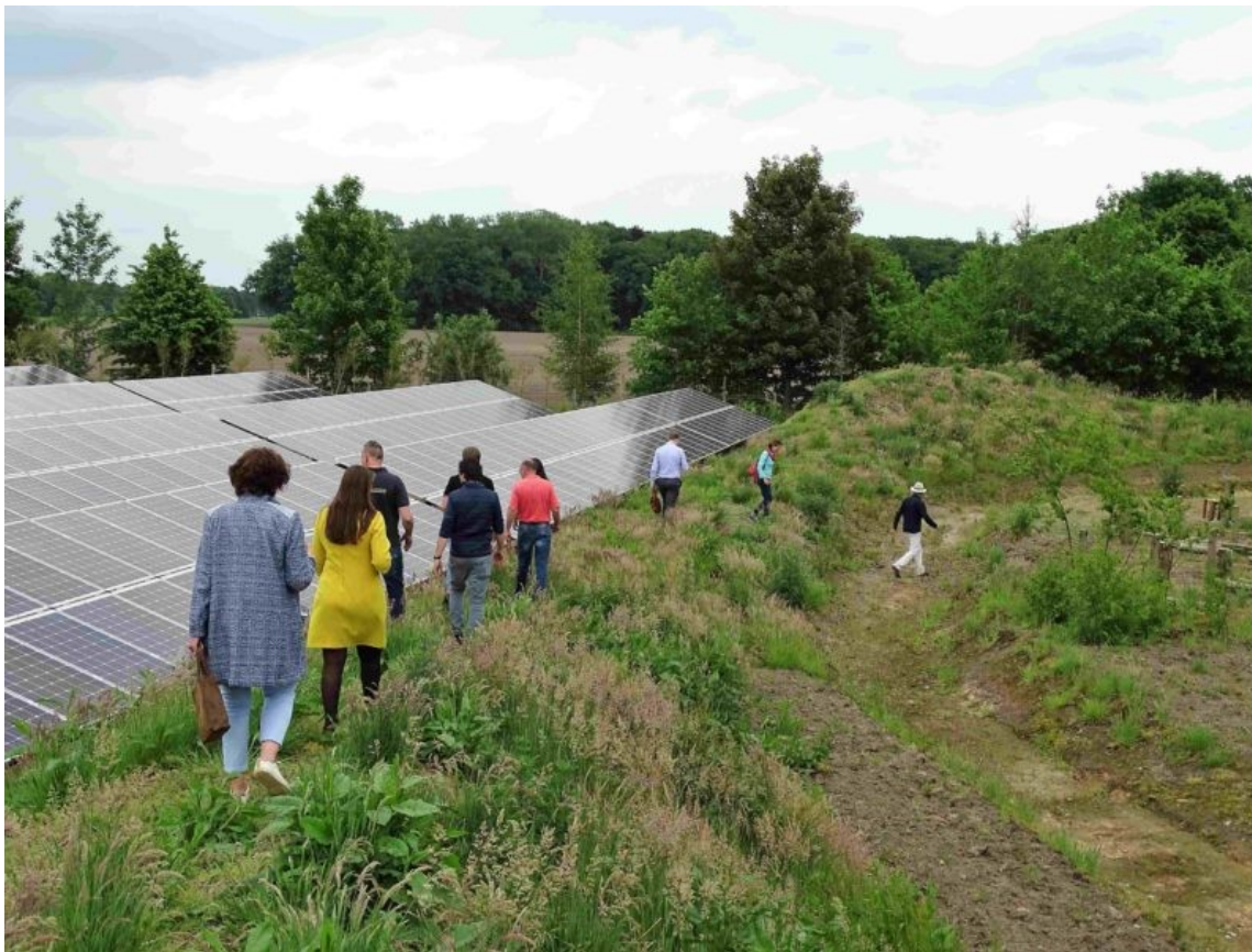
Solarpark de Kwekerij, Hengelo
