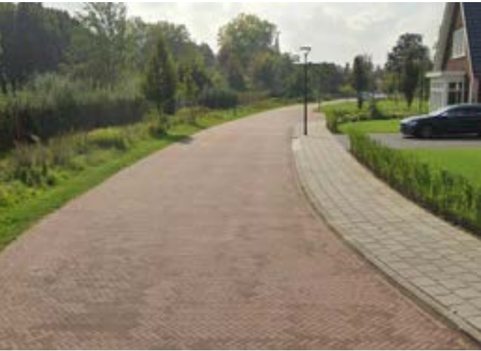
Referentie: rijbaan met trottoir (Stekweg)
