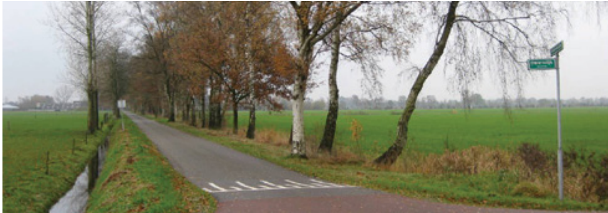
Deze kaarsrechte weg, Hobelmandijk, in het Wolfersveen, bestaat uit grond dat is opgeworpen uit de sloten.
