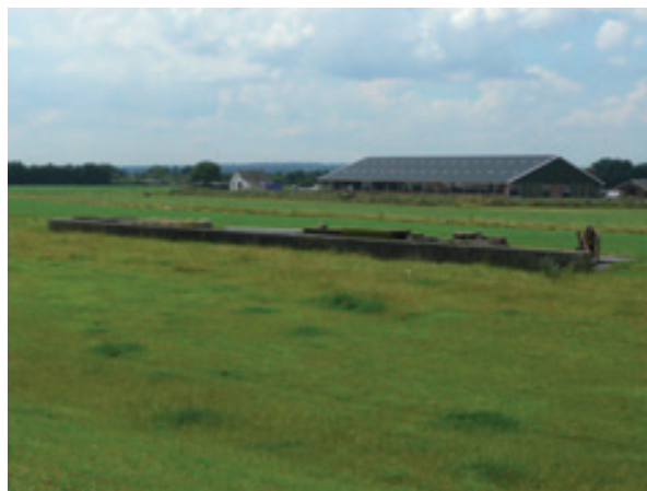
Inlaatsluis bij Olburgen.
