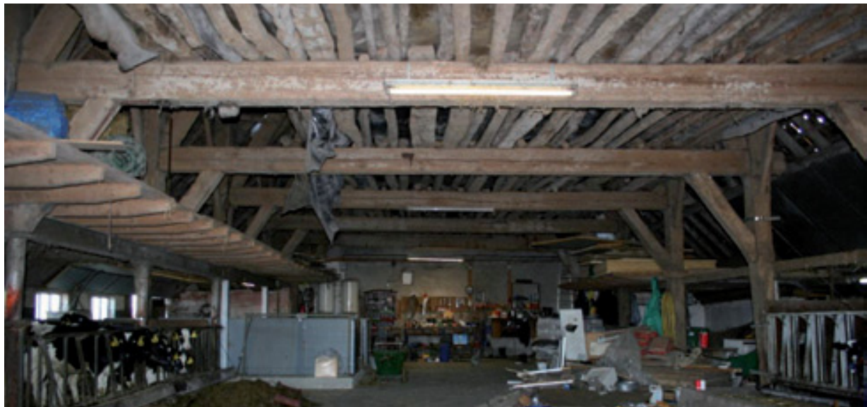
Blik in het achterhuis van de boerderij aan de Emmerweg 10 in Steenderen. Het middengedeelte is in gebruik als deel en in de zijbeuken zijn stallen gemaakt.
