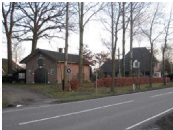
Zicht vanaf de Sliekstraat op de Villa Berkenhof uit 1933 met links daarvan het voormalige koetshuis.
