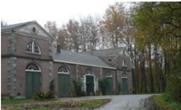
Voormalig koetshuis Enghuizen.
