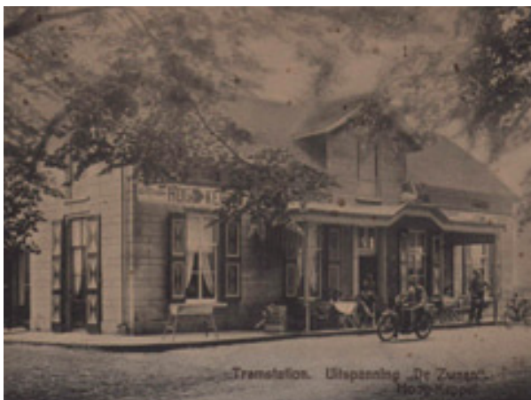
De Zwaan gelegen aan de Rijksweg N317 te Hoog-Keppel.
