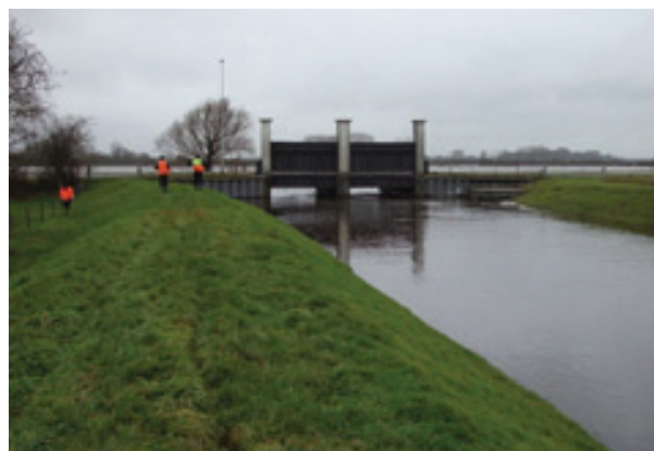
De uitwateringssluis van het Stroomkanaal Hackfort, gegraven in 1952 (foto: www.wrijj.nl ).
