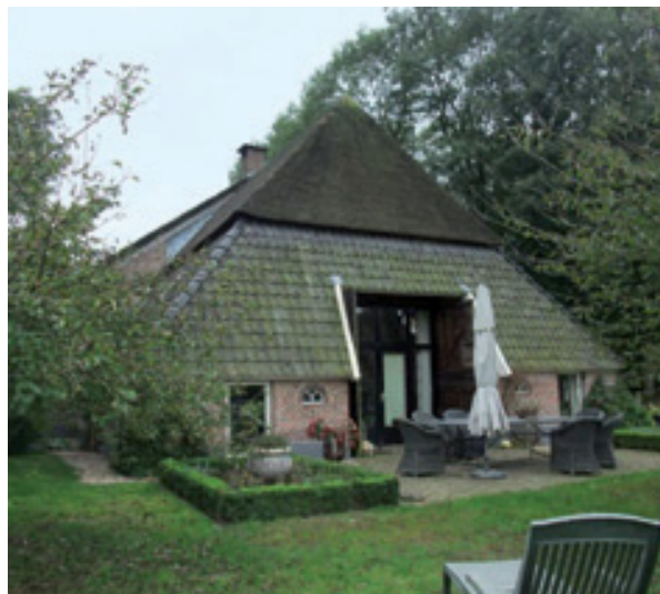
De onderschoer in de achtergevel van boerderij Spiekerman in Vorden.
