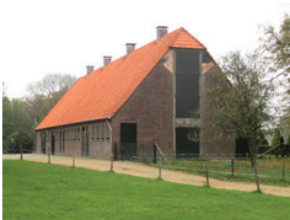
Schuur boerderij Nieuw Enghuizen in Laag Keppel.
