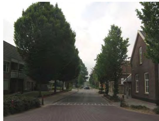
Foto huidige situatie; boom staat te dicht op woning en zorgt op langere termijn voor problemen.
