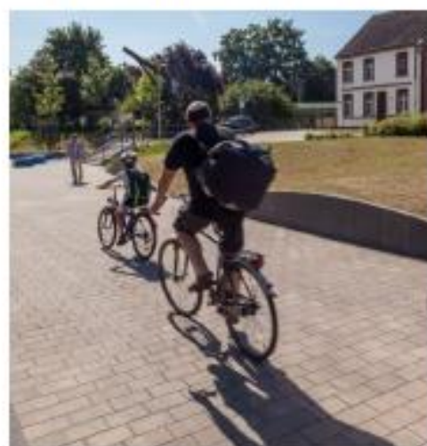
Fietspad - betonklinker beige (kleinformat)
