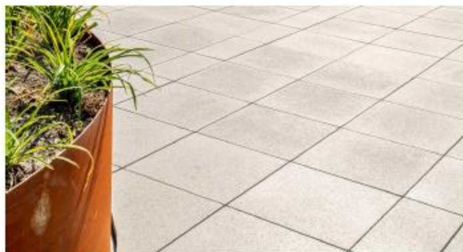
Voetgangersgebied - betonklinker beige/zand, grootformaat, blokverband
