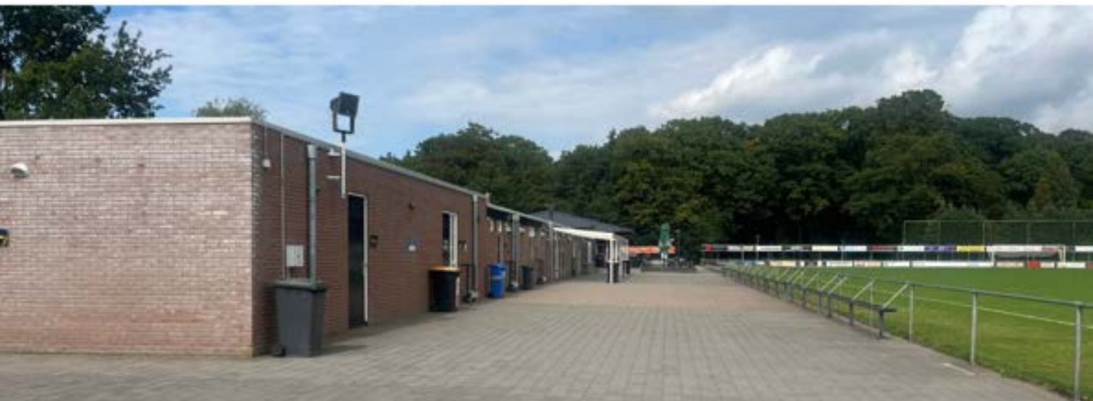
ZZC'20 locatie Pluimersdijk
