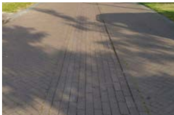
Brede goot t.b.v. hemelwaterafvoer parkeercoffers
