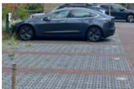
Parkeervak in parkeerkoffer Waterdoorlatende verharding
