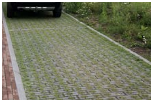
Ontsluitingslus: langsparkeerstroken van grasklinkers
